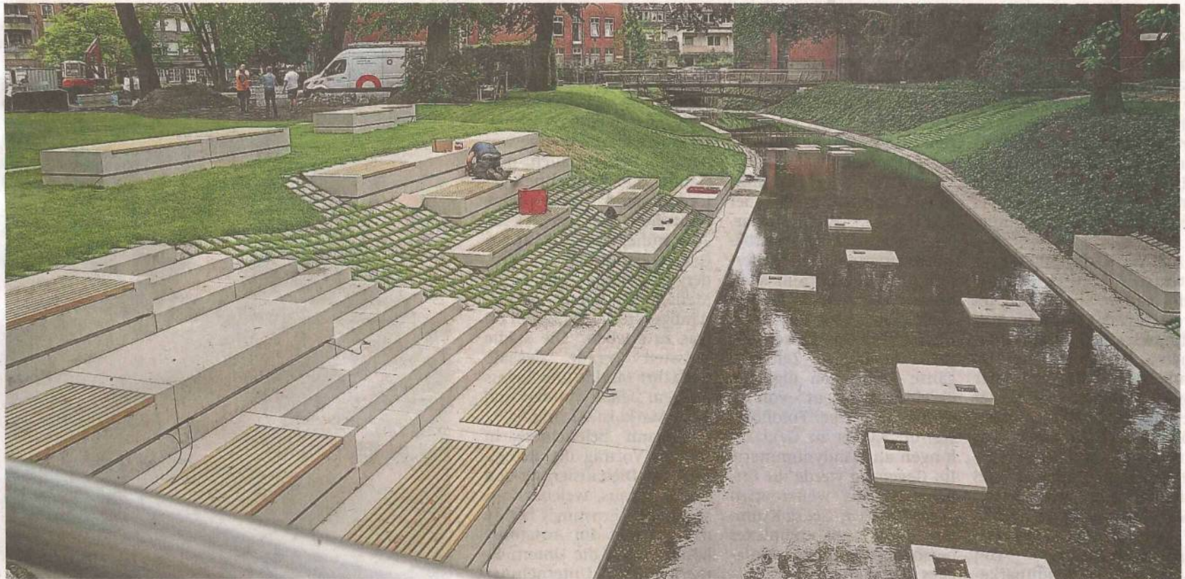
Die Berkel fließt wieder im Schlosspark. Zurzeit arbeitet die Stadt daran, den richtigen Wasserstand und die Fließgeschwindigkeit einzustellen.
