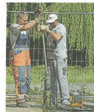
Mathias Graf mit einem Mitarbeiter bei einer Sondierungsbohrung auf dem Mühlengelände. MLZ-FOTO
