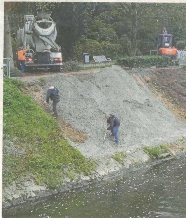
Beton wurde auf die Uferböschung der Berkel gegeben, damit diese einigermaßen befestigt ist und einem Hochwasser Stand halten würde. MLZ-FOTO SCHLEY
