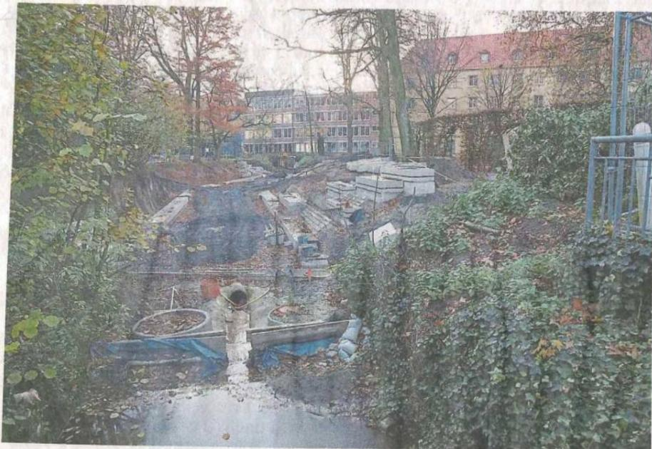
Die Berkel wird durch ein Rohr unter dem Schotter durchgeführt, so dass die Arbeiter dort, wo früher eine Brücke stand, besser arbeiten können.
