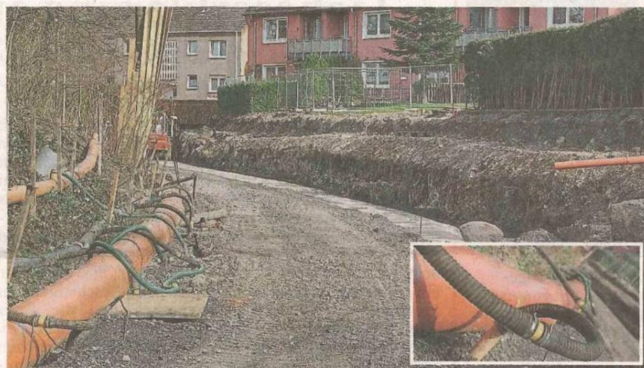
**Bagger können** nur durch das Berkelbett rollen, weil der Weg oben zu schmal ist. Die Berkel wird zurzeit durch ein 400er-Rohr geleitet, neben dem Spüllanzen (kleines Foto) für die Senkung des Grundwasserspiegels zuständig sind.
