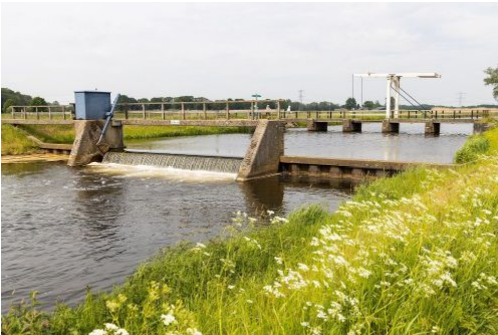
Stuw en brug Velhorst
