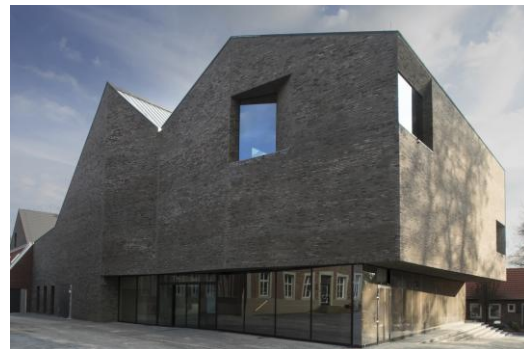
Abbildung 2: Eingangsbereich des kult
