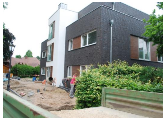
Abbildung 20: Wohnneubau am Butenwall
